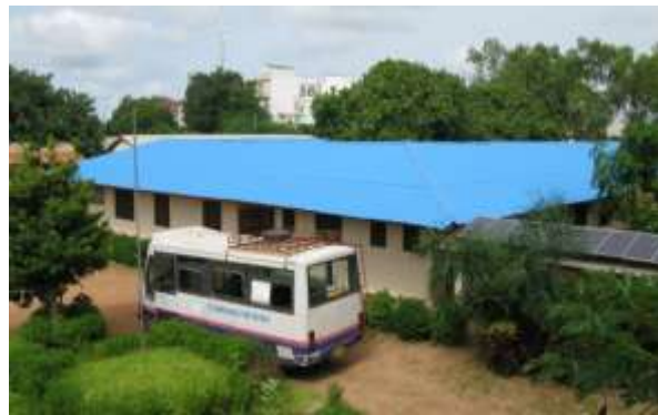
Het dak is vernieuwd. We zitten weer droog.
