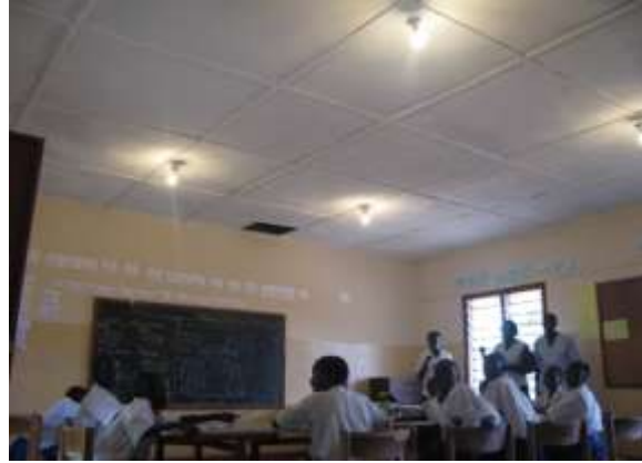
In de klas is het met het nieuwe plafond een stuk lichter.
